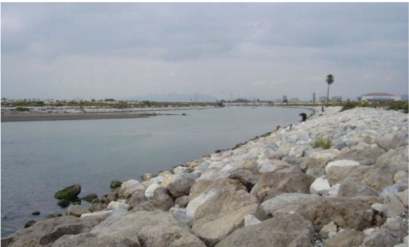
Digue anti-inondations construite sur le Guadalhorce, en Espagne, peu après son achèvement en 2003. Une double digue a été bâtie pour éviter que les inondations catastrophiques de 1989 ne se reproduisent.
