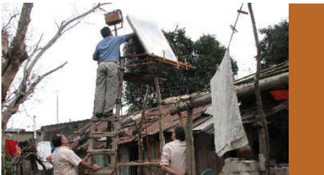
Instalación de calentadores solares.
