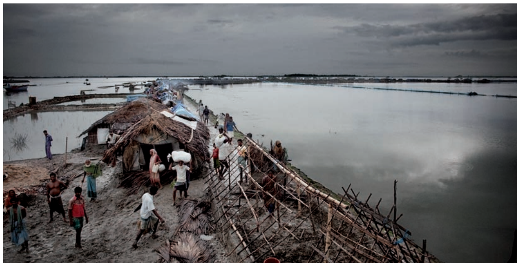
孟加拉国帕得玛·帕库尔 (Padma Pakur) 岛上的防洪设施。在村庄和海水之间种树，防止海水侵蚀并作为防风林。
