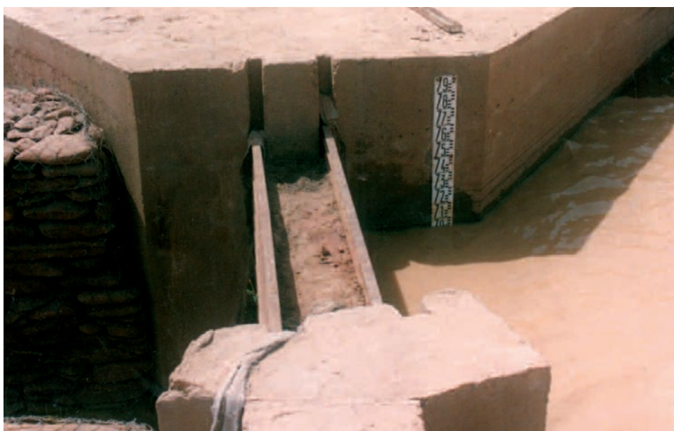
Photo 14: Vidange par passe batardée du barrage de Guévéra (Assaba); bajoyers amont en béton; bajoyer aval et zone de dissipation en gabions; batardeaux en poutrelles métalliques IPN.
