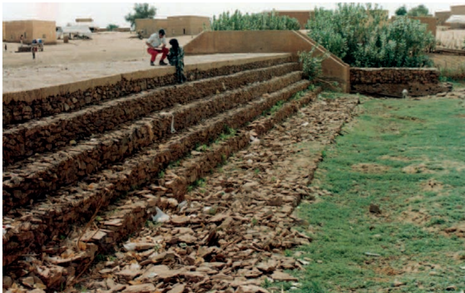
Photo 13: Barrage de Sangarafa (Brakna). Vue du déversoir à seuil épais en béton, suivi d'un dissipateur d'énergie en gradins de gabions et d'un bassin de dissipation sommaire en enrochements. Le dispositif a prouvé son efficacité car cet ouvrage est déjà ancien et aucun dégât majeur n'y est apparu.
