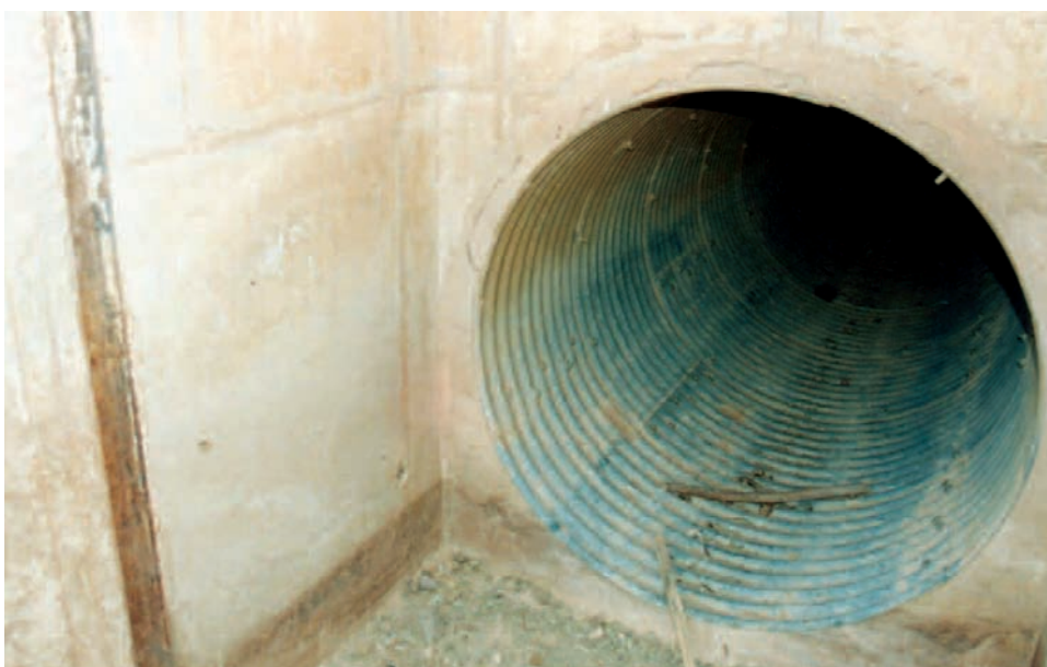
Photo 16: Partie amont de la vidange du barrage de Leklewa (Brakna). Détail de la liaison entre la buse ARMCO et la passe à batardeau.
