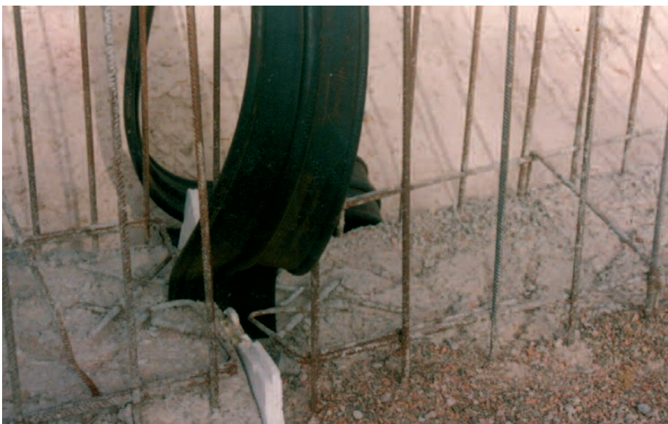
Photo 8: Vue d'un joint de construction. La séparation physique entre les deux plots est obtenue en intercalant une plaque de polystyrène; l'étanchéité est assurée par le joint waterstop, dont chacune des bandes est coulée dans les deux plots.
