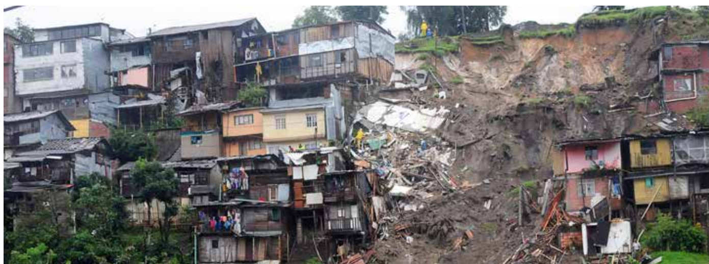
Crédito de la foto: Vista de un deslizamiento de tierra que destruyó varias casas en Manizales (Colombia), el miércoles 19 de abril de 2017. Al menos siete personas resultaron muertas después de que las intensas lluvias provocaran varios deslizamientos de tierra en una zona montañosa cafetera de Colombia. (AP Photo/María Luisa García)
